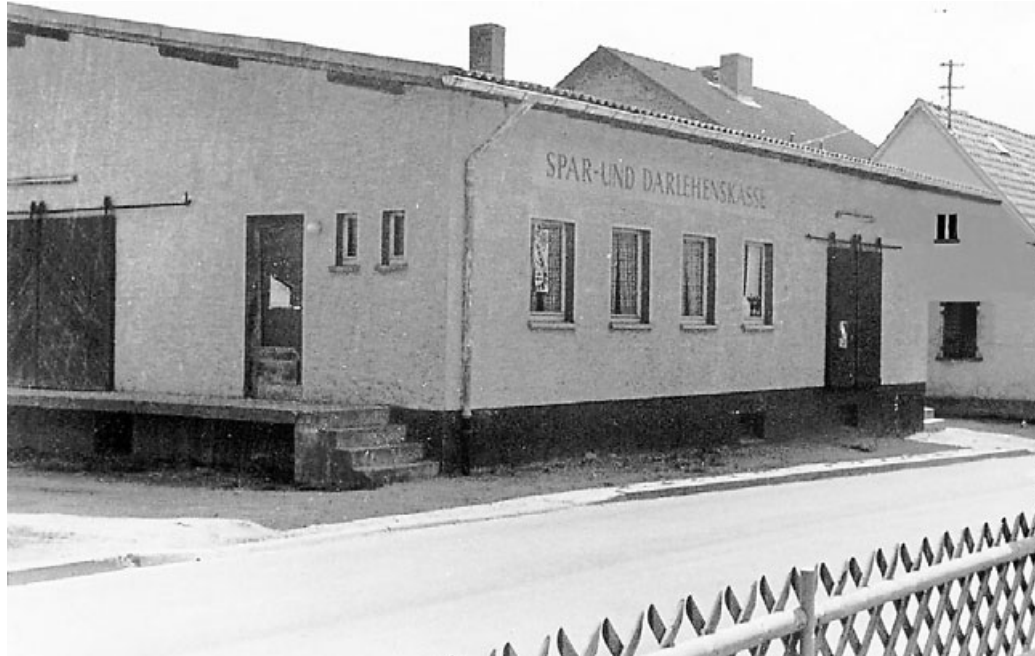
Das ehemalige Lager und Büro der Spar- und Darlehenskasse.
